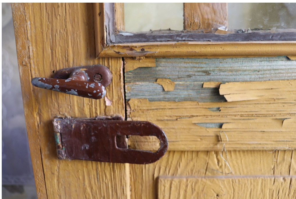
fot. 4: Kapliczka domkowa - widoczne metalowe zamknięcie drzwi oraz ubytki farby olejnej odsłaniające drewno.
