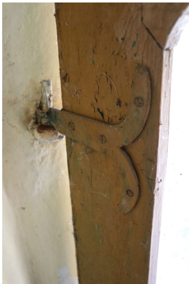
fot. 3: Kapliczka domkowa - metalowe okucie pokryte farbą olejną.
