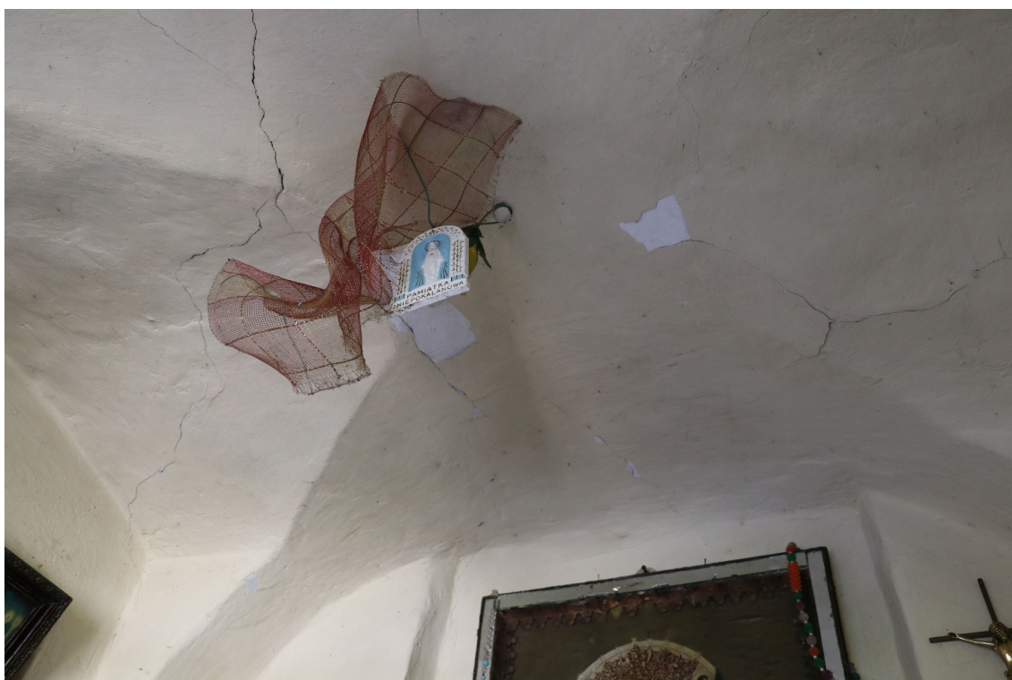
fot. 17: Kapliczka domkowa - widoczne spękania sklepienia oraz złuszczenia farby wierzchniej.
