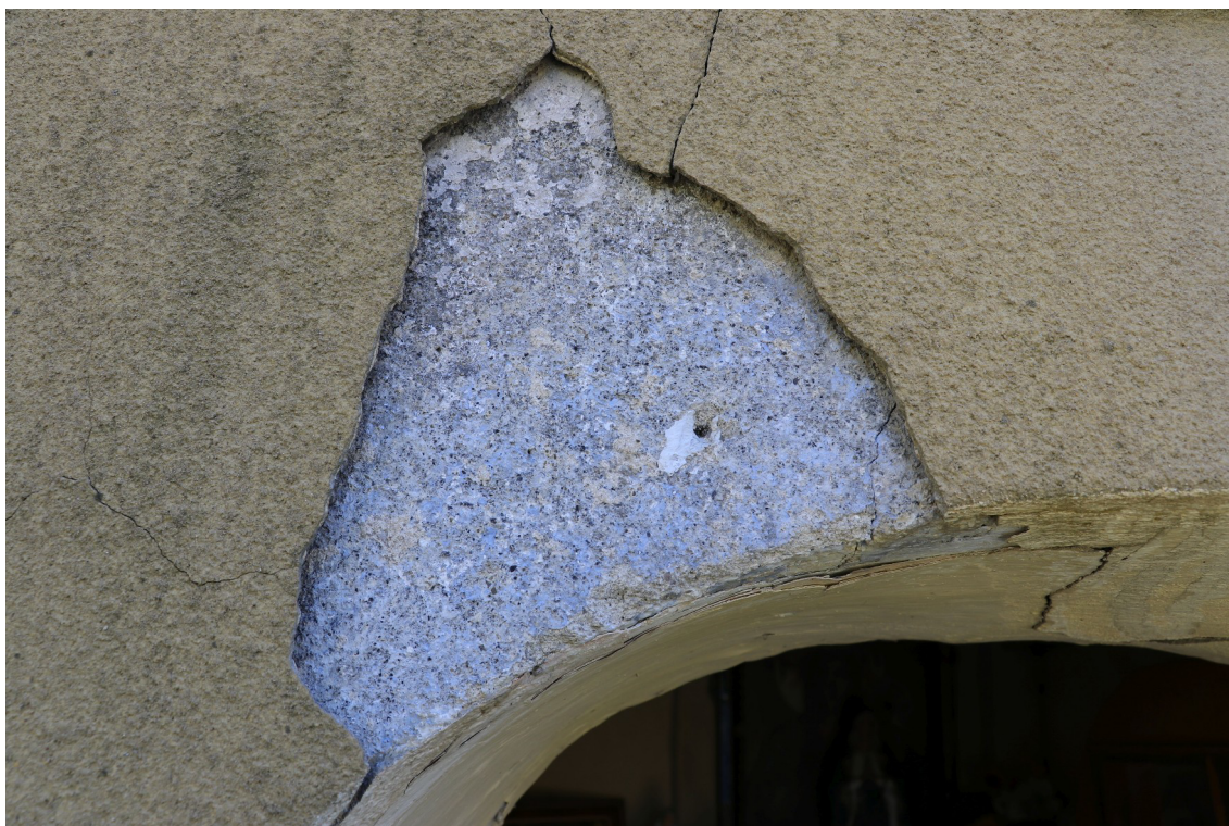
fot. 5: Kapliczka domkowa - naturalna odkrywka ujawniające pierwotny tynk wapienno - piaskowy.
