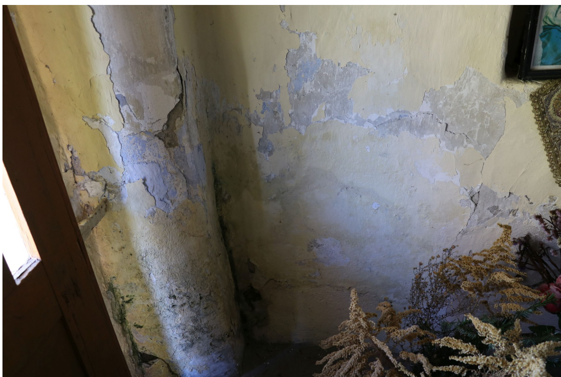
fot. 16: Kapliczka domkowa - widoczna degradacja tynku w dolnej partii ściany.
