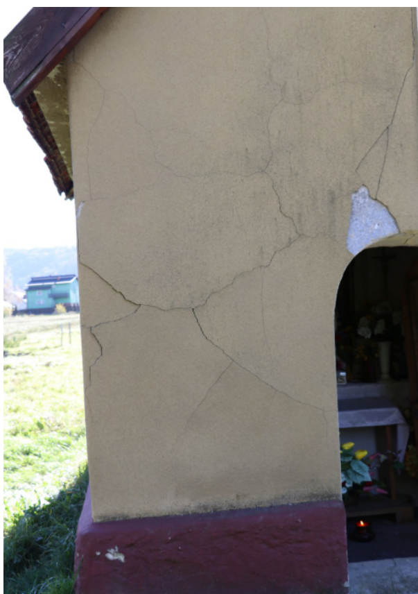
fot. 8: Kapliczka domkowa - widoczne spękania tynku wtórnego na elewacji frontowej.
