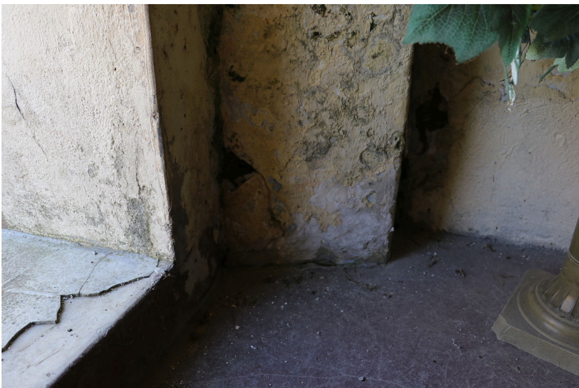
fot. 18: Kapliczka domkowa - widoczne uszkodzenia tynku przy linii posadzki i drzwi wejściowych do kapliczki.
