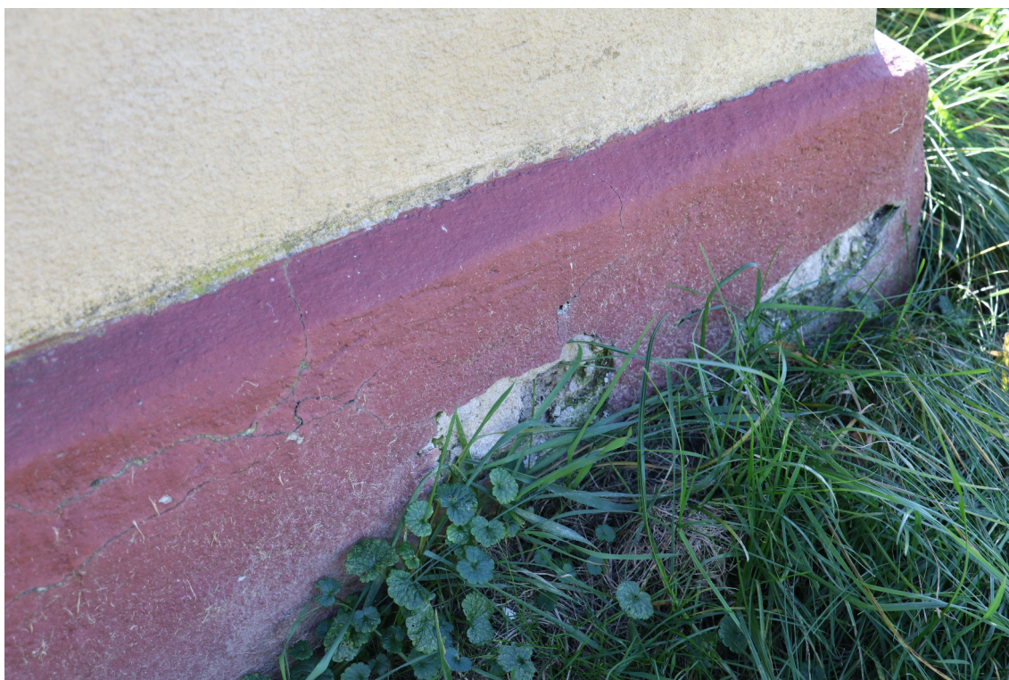
fot. 6: Kapliczka domkowa - widoczne uszkodzenia tynku cokołu elewacji frontowej.
