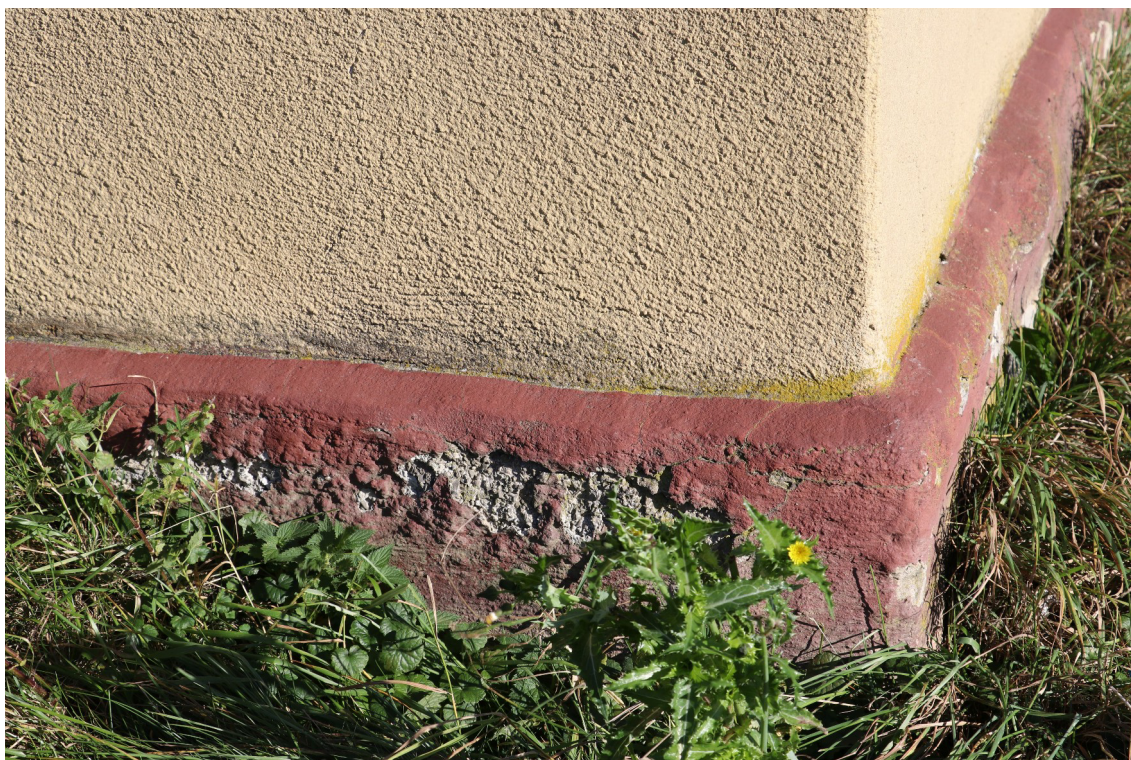
fot. 12: Kapliczka domkowa - widoczne ubytki tynku cokołu elewacji bocznej.
